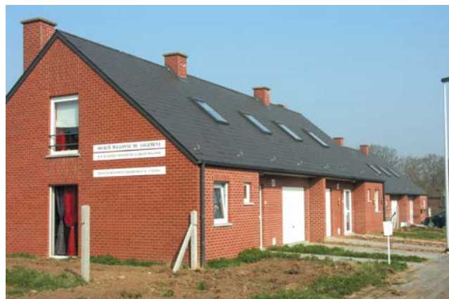
Logements rue des Cots à Trivières
