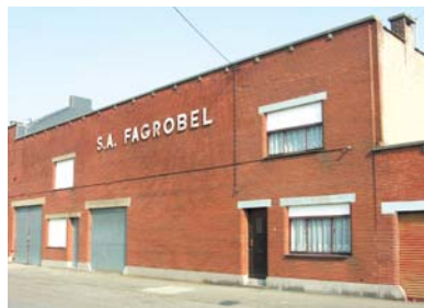
Rue Zénobe Gramme à La Louvière site industriel "Fragobel" projet de réhabilitation en 20 logements
