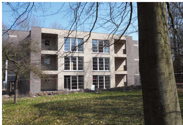
Construction de six appartements cité Parc Bois du Hameau à Manage
