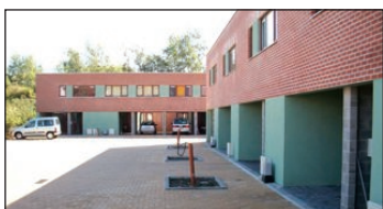
10 maisons destinées à la location -Rue Larcimont à La Louvière
