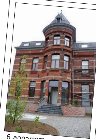
6 appartements destinés à la location, rue Delfosse, 1 à Manage
